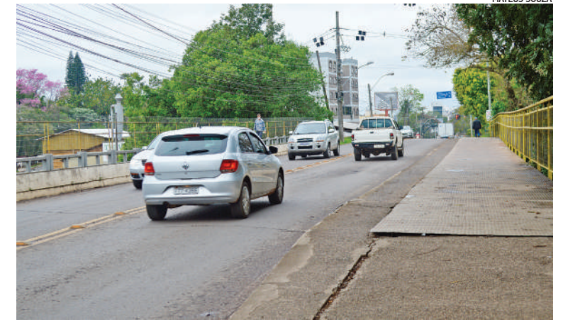
Para facilitar o tráfego, viaduto terá duas pistas com o alargamento
