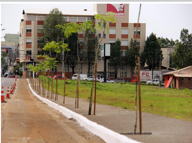
Foto 14 – Plantio na Avenida Pirai finalizado;
