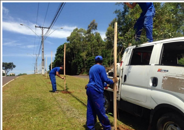
Foto 33 – Colocação de estacas de 3,0 m;
