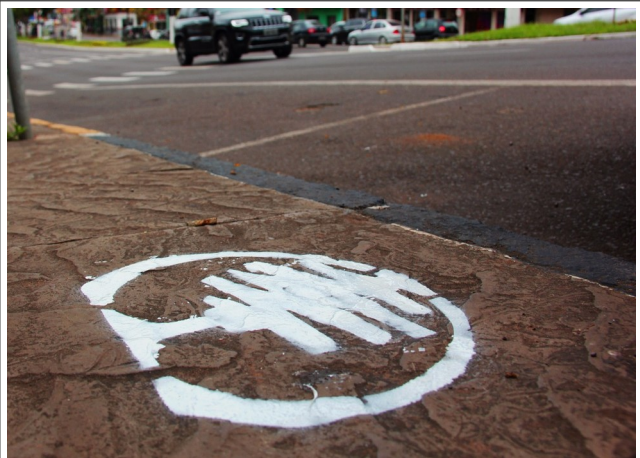
Foto 2 – Demarcação de local para abertura de canteiro;
