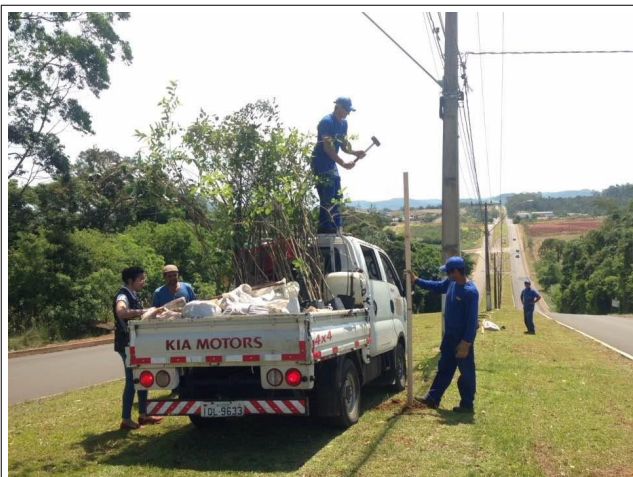
Foto 31 – Equipe de plantio da Secretaria de Obras e Serviços Públicos (SEOSP);
