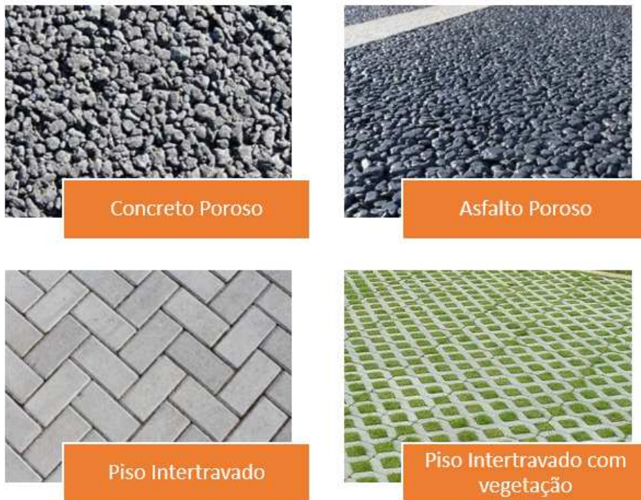
Figura 39: Pavimentos permeáveis. Fonte: Engenharia 360.
