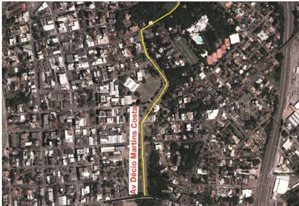
Figura 5: Localização da parte final da canalização do arroio do engenho
