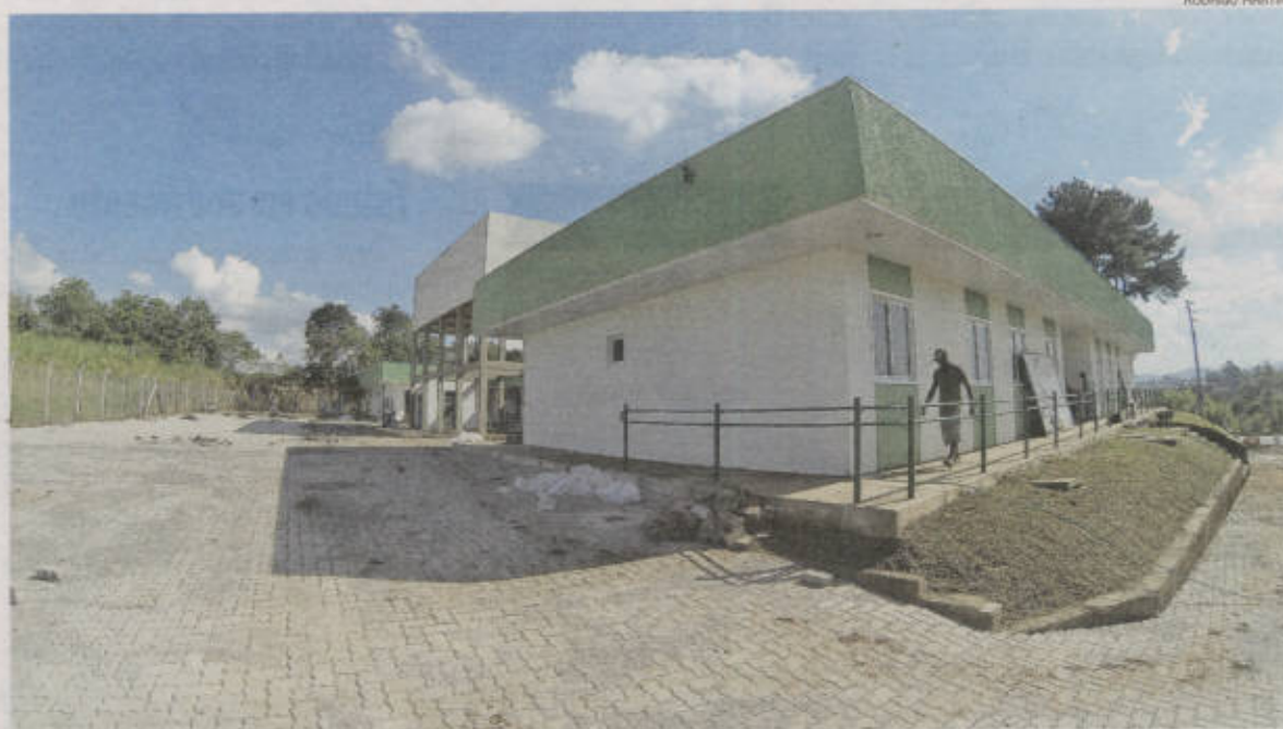
Pronta desde dezembro de 2012, estrutura ainda recebe obras e serviço pode iniciar com quadro incompleto de funcionários
