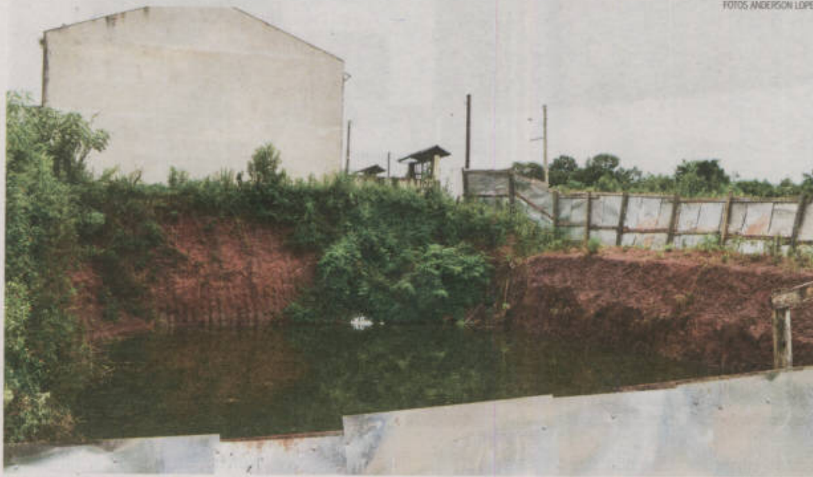
Escavação na esquina entre a avenida Ari Stürmer e a rua João Adolfo Marder tem cerca de 550 metros quadrados
