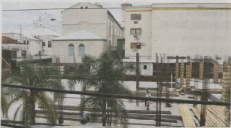
Em Estrela , retomada de obra solucionou problema semelhante
