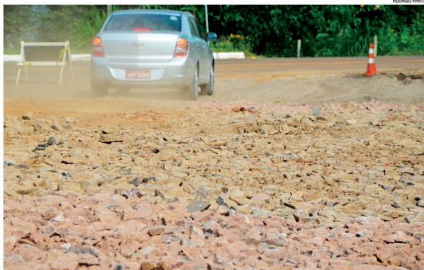
Se for aprovado, novo modelo permitirá obras sem processo licitatório e sob gerência dos próprios moradores
