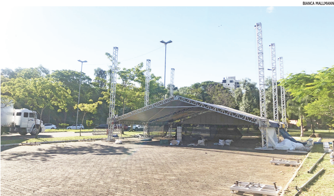
Estrutura do palco começa a ser montada no Parque dos Dick. Serão seis atrações durante os três dias de evento
