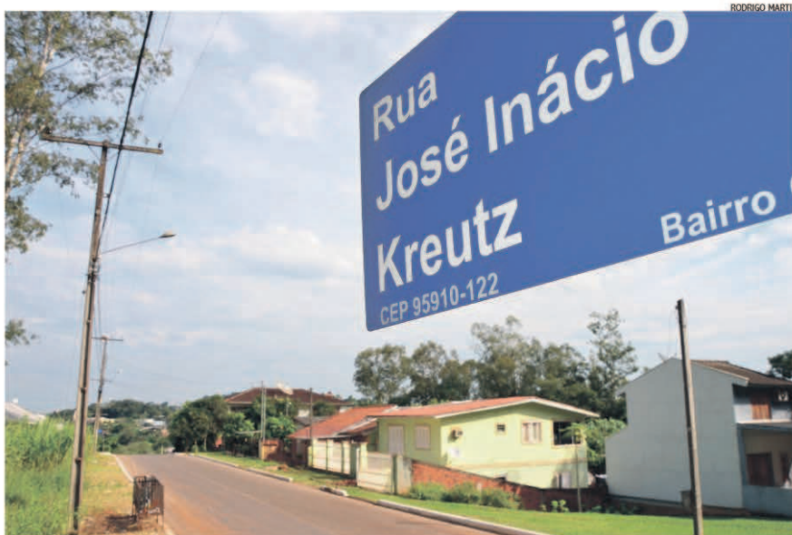
Rua no Olarias foi pavimentada por meio da Contribuição de Melhoria, mas moradores não querem pagar
