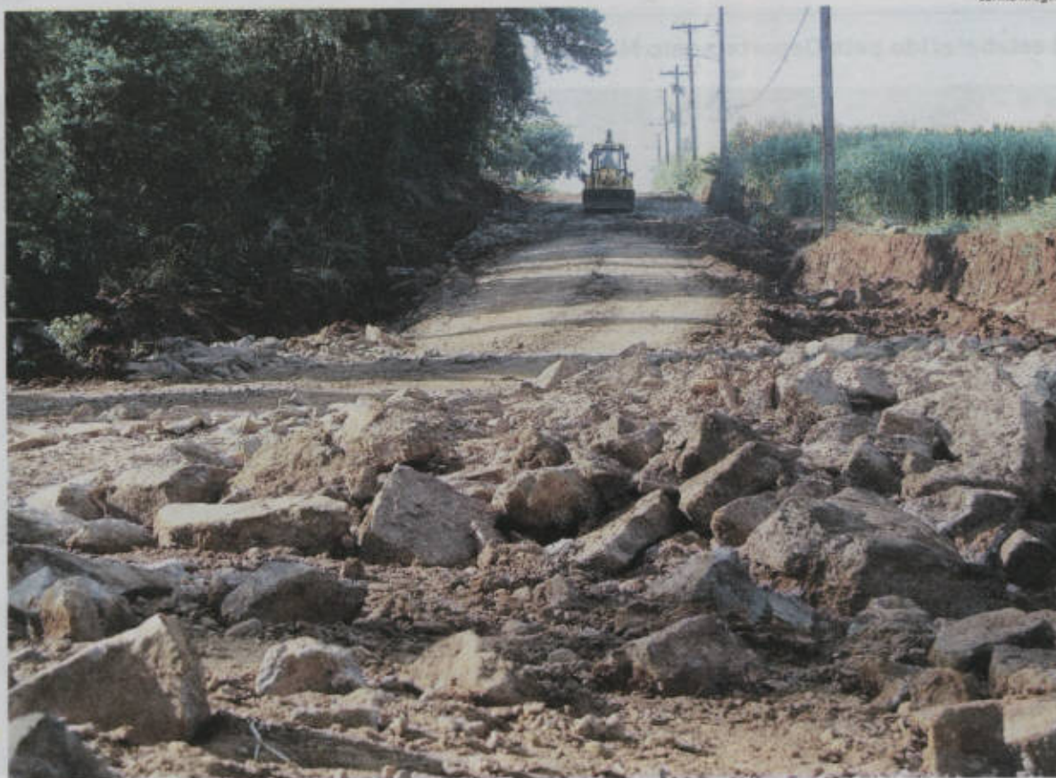
Rua onde moradores assaram churrasco em buracos está sendo reformada
