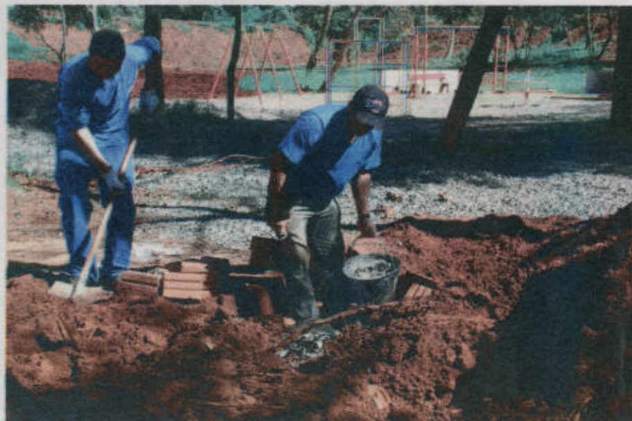
Construção de calçada e obras de canalização pluvial fazem parte da revitalização
