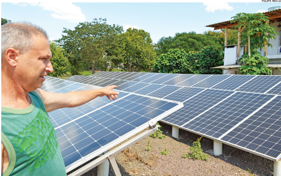
Heitor Luiz Groders, de Forquethina, investiu mais de R$ 100 mil na instalação de 73 placas fotovoltaicas
