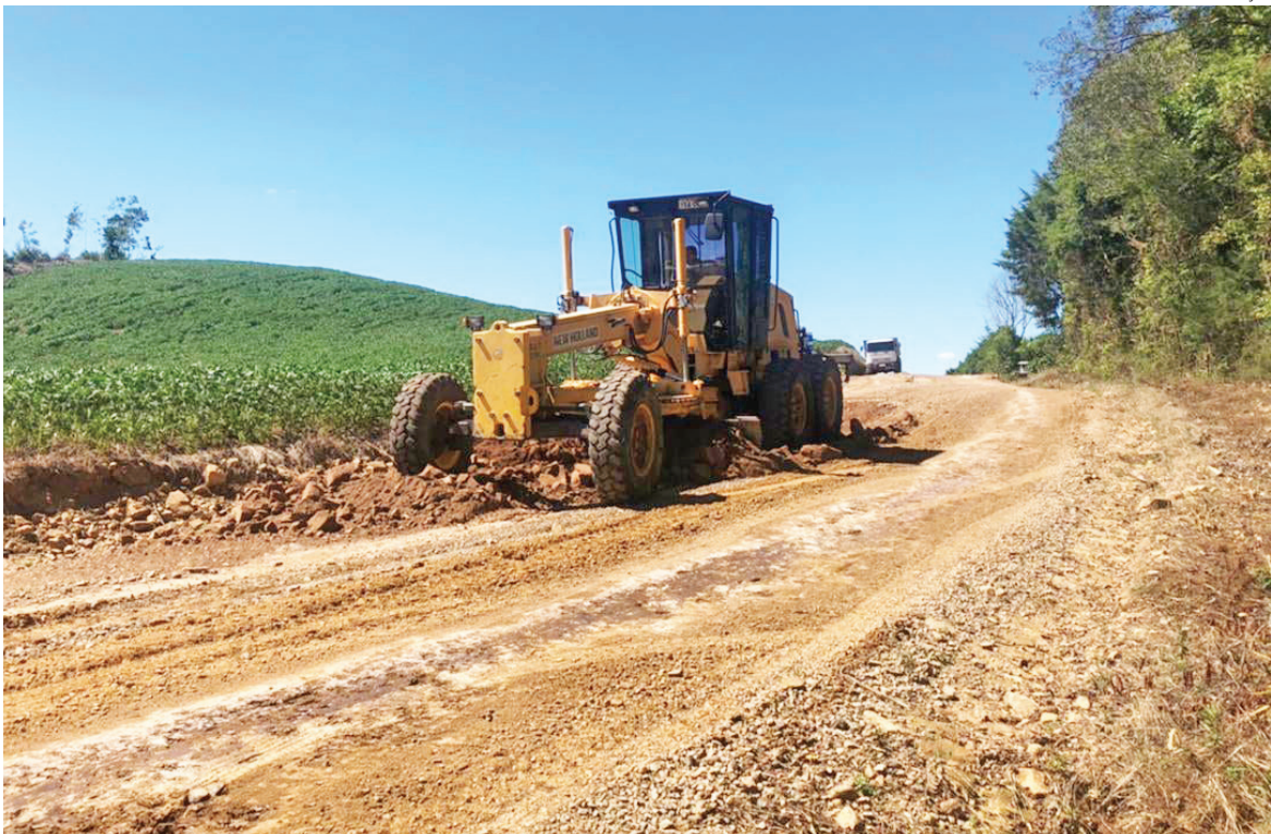
Em meio a estiagem, Secretaria de Obras busca melhorar as estradas no interior de Arvorezinha
