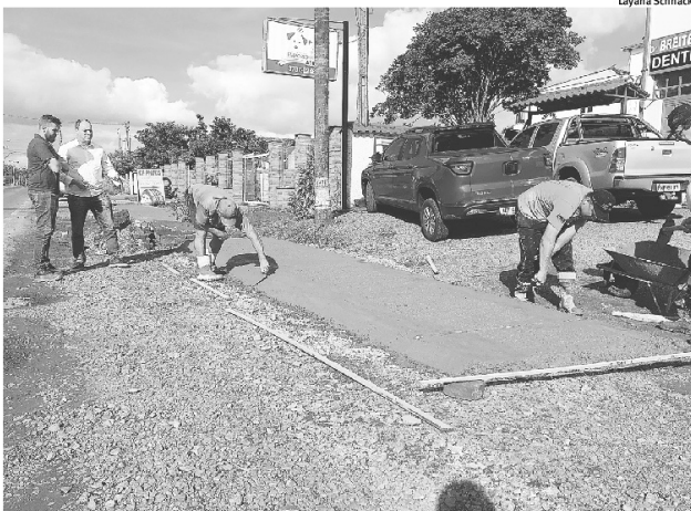
OBRA: nesta etapa investimento será de R$ 70 mil
