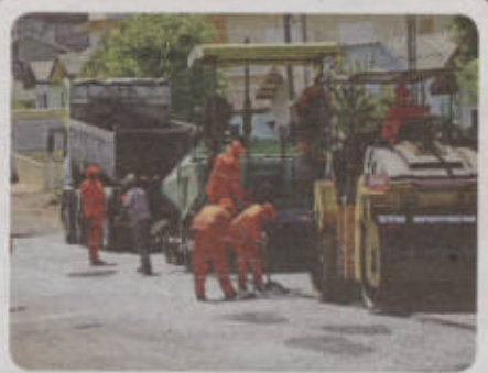
ASFALTO NA RUA HENRIQUE WENDT
