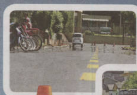
ASFALTO NA RUA MENNA BARRETO
