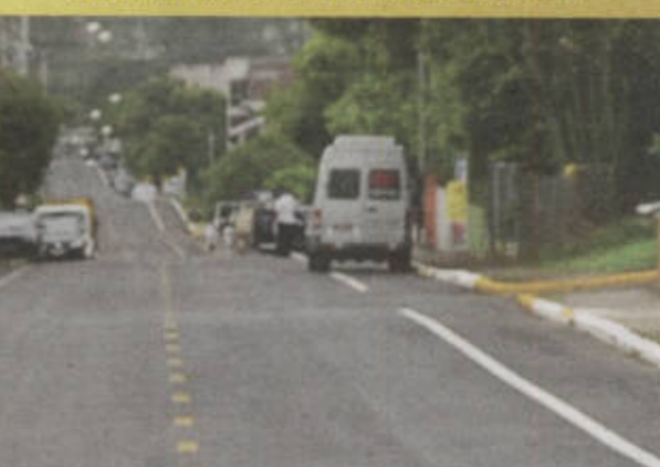
ASFALTO NA RUA FREDERICO SULZBACH
