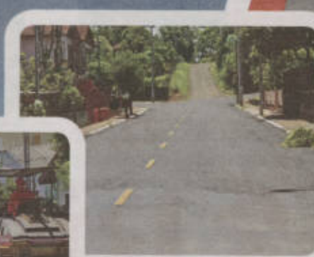
ASFALTO NA RUA MARECHAL HERMES
