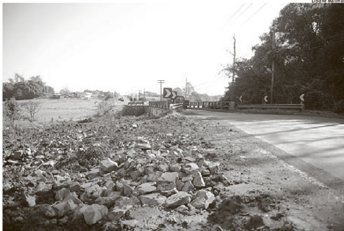
PREPARADO: terreno está pronto para receber o início da construção da nova ponte
