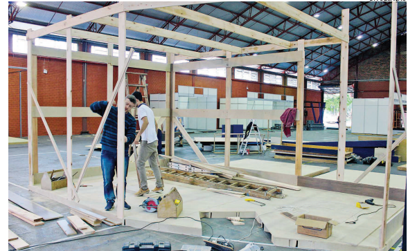
Estruturas para o evento começam a ganhar forma no Parque do Imigrante
