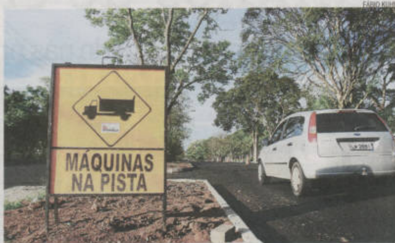
Governo faz melhorias na av. Alberto Müller, acesso ao Parque do Imigrante
