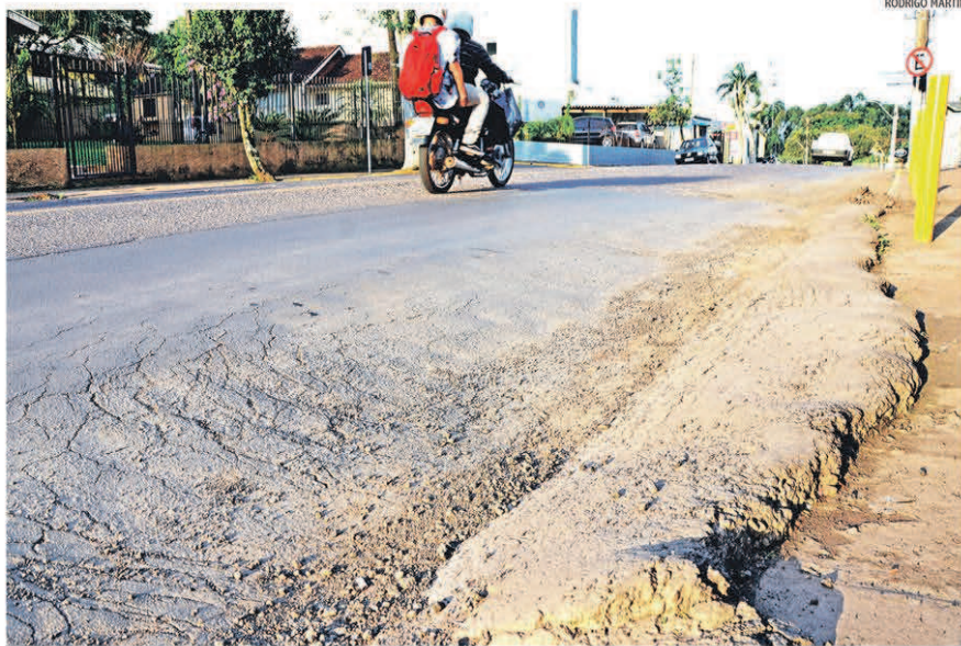
Rua Carlos Spohr Filho, no bairro Moinhos, será uma das beneficiadas com serviços de recalpeamento do asfalto
