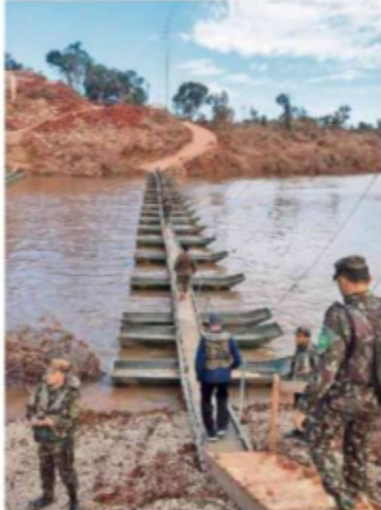
Passarela pínel montada pela força entre Arroio do Meio e Lajeado
