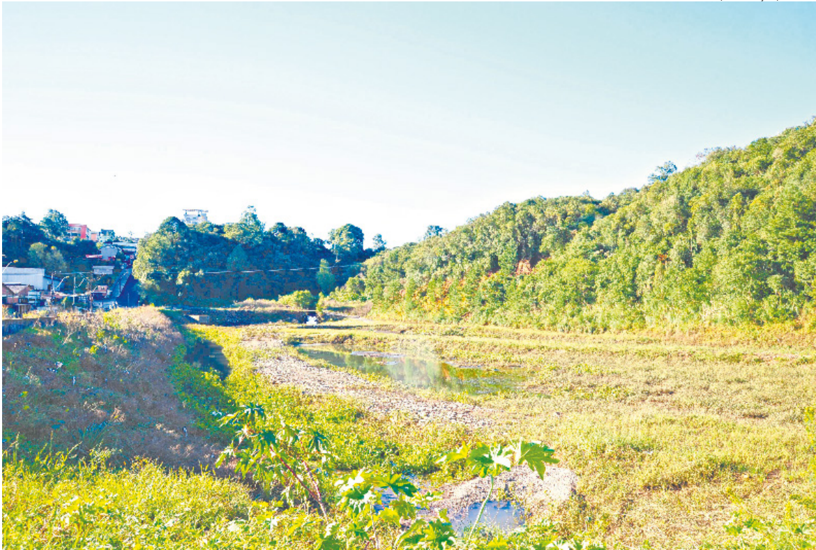
Seis tanques de contenção, como o São José (foto), servem para atrasar a evolução da água pluvial na cidade
