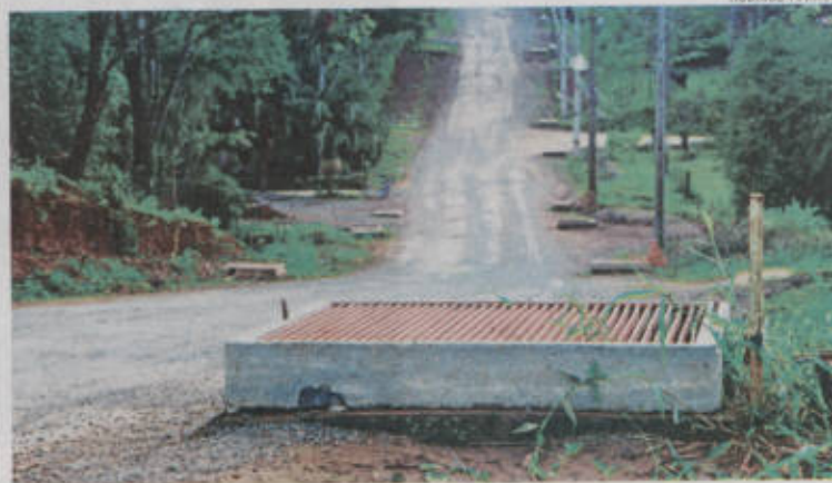
Cercadas de polémicas e suspeitas de irregularidades, as obras do PAC são o retrato de como o serviço público insiste em atrapalhar a vida das pessoas
