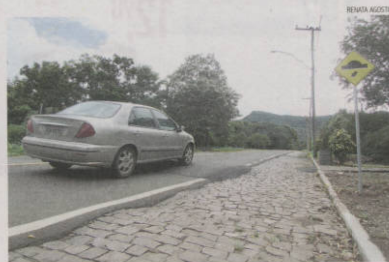
Pintura dos redutores deve ocorrer na próxima semana
