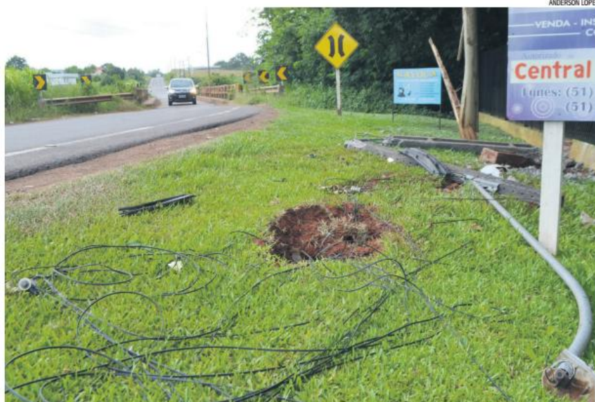
Acidente mais recente aconteceu no domingo. Registros são constantes no ponto mais perigoso da ERS-413
