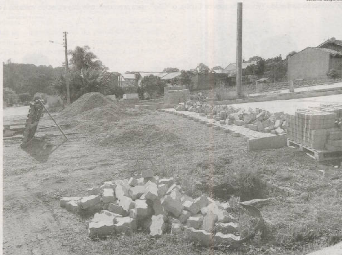
Obra de calçamento na Avenida Aury Stürmer está parada. Moradores fizeram abaixo-assinado
