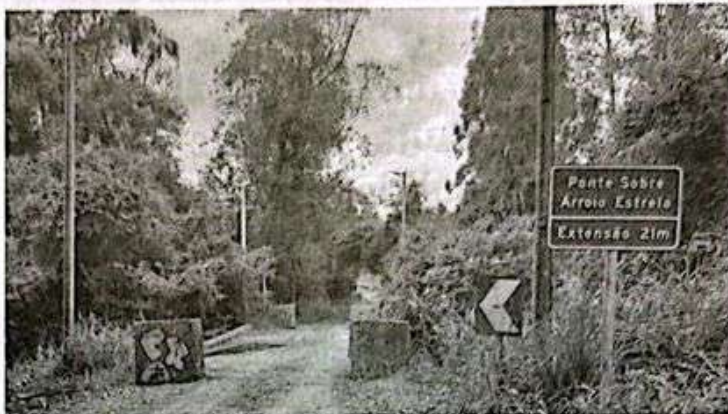
Obra garante segurança, mobilidade e retomada do escoamento da produção primária do interior do município; recursos são assegurados pela Defesa Civil Nacional
