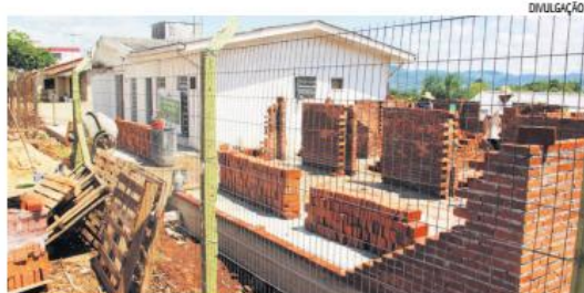
Conclusão da obra da unidade no Campestre está prevista para março de 2017
