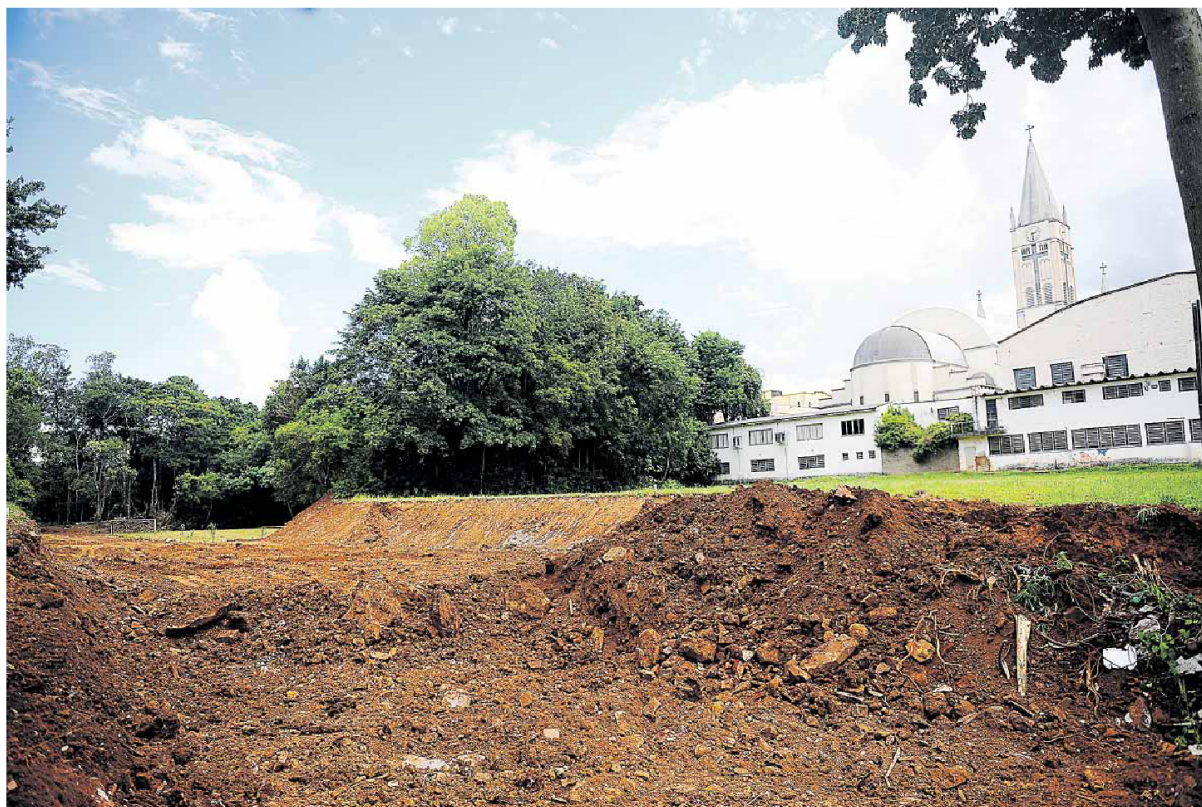
OBRAS: prolongamento da Capitão Leopoldo Heineck até a Oswaldo Aranha
