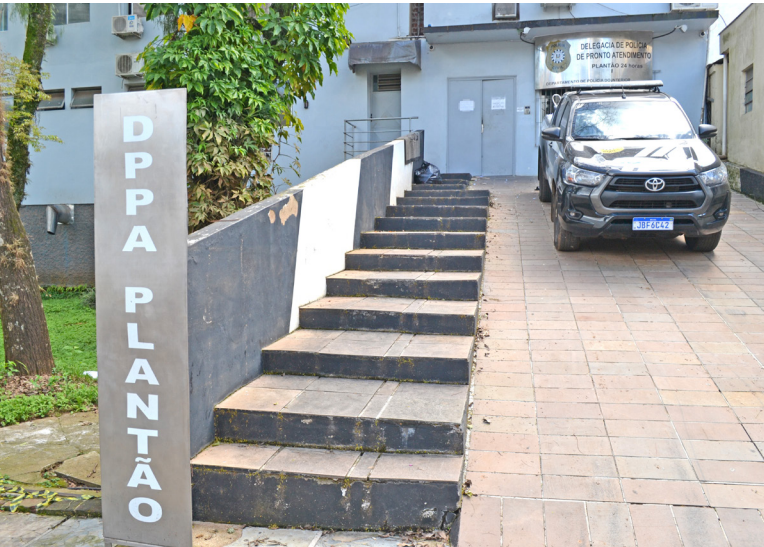
Atual prédio da Central de Polícia sofre com problemas estruturais
