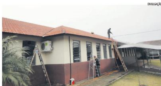
Secretaria de Educação faz reparos em escolas durante férias escolares
