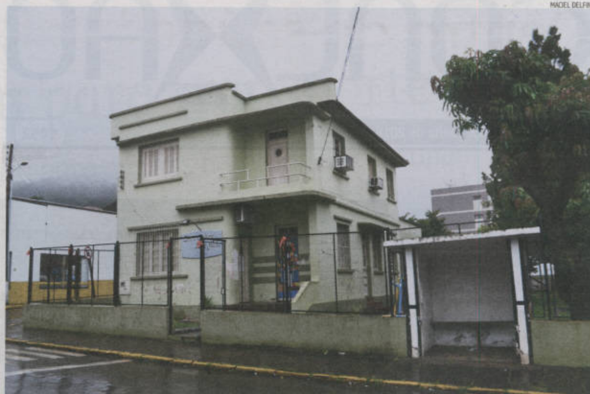
Infraestrutura do Centro Cultural 25 de Julho não comporta shows, apenas aulas
