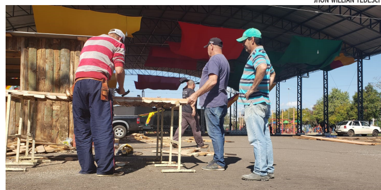
Estrutura foi montada no Parque Princesa do Vale
