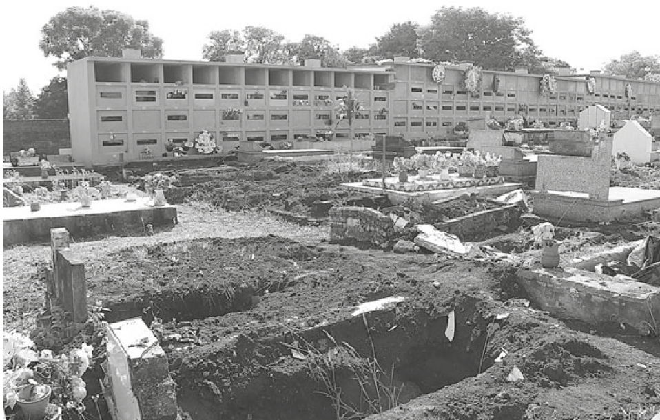
CRONOGRAMA: obras de construção de gavetas devem iniciar na próxima semana
