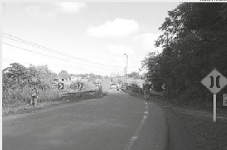
SERVIÇO: Daer iniciou ontem os trabalhos, entre eles o de roçadas, que antecedem a construção da nova ponte
