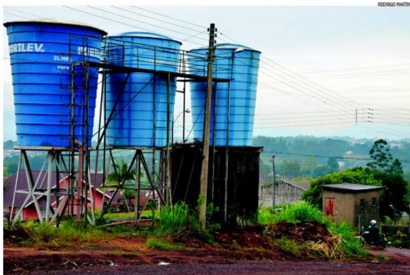
Na rua José Franz, em Conventos, governo deve instalar mais dois reservatórios de 25 mil litros. Serviço começa em maio
