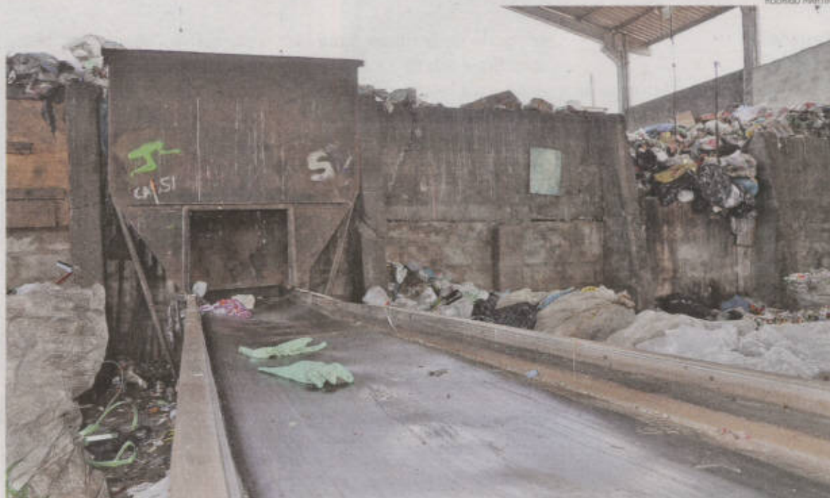
Condições de trabalho são adequadas. Acidentes semelhantes já aconteceram no local e lesaram operários
