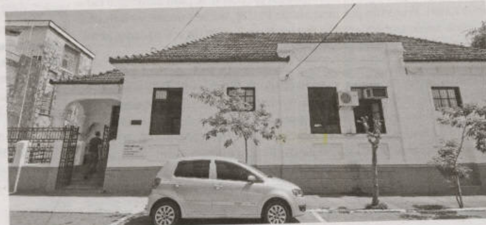
Sede da Saúde fica na área central, a uma quadra do calçadão
