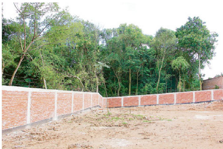
EMEI MUNDO ENCANTADO: entre as escolas que passam por melhorias está a do Bairro Morro 25, que teve o muro dos fundos reconstruído
