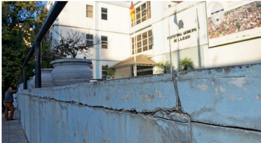
Pintura e manutenções em rebocos, telhado e divisórias estão orçadas em até R$ 129 mil pelo governo municipal
