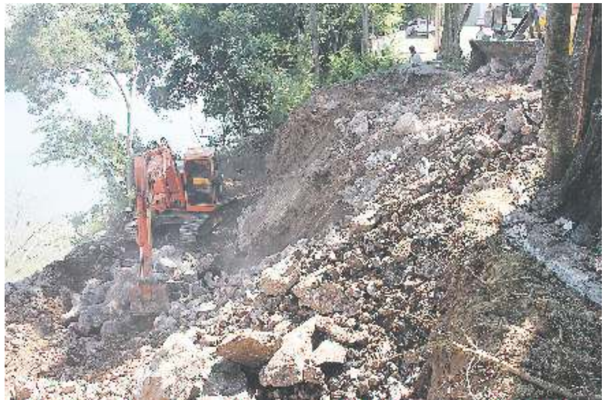
Ontem, máquinas trabalhavam a todo o vapor na Rua Oswaldo Aranha
