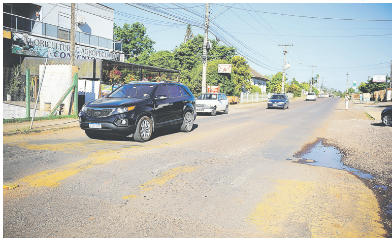
Rodovia 421 une Lajeado a Forquetinha e tem grande fluxo de veículos e pessoas
