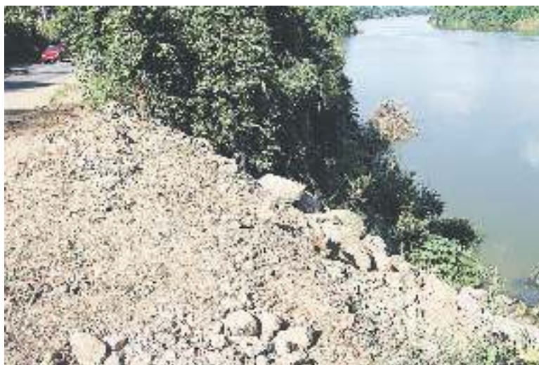
Na Avenida Beira-Rio, ainda não há frentes de trabalho
