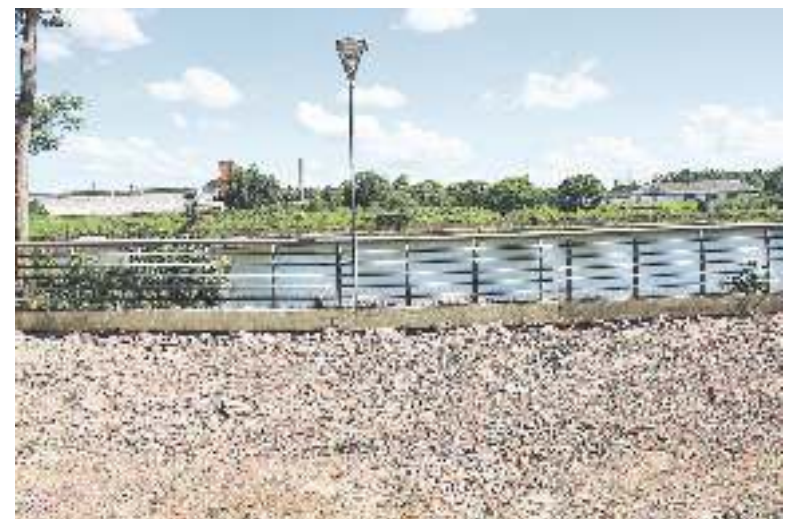
Belvedere está parcialmente refeito
