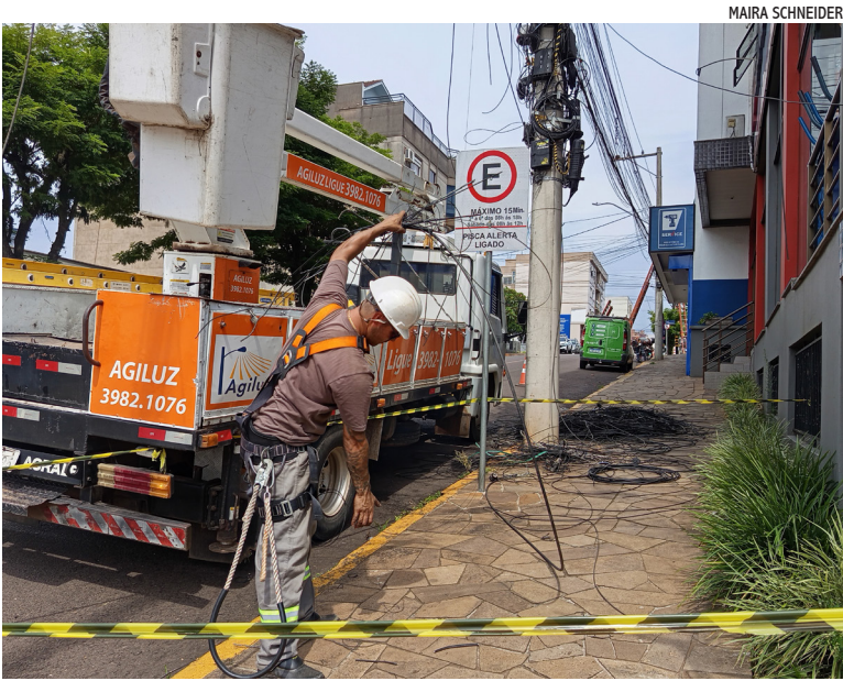
Equipes da prefeitura e de telecom atuaram na retirada de fios ociosos no bairro Americano. Ao longo do ano, estão previstas 15 ações de grande porte
