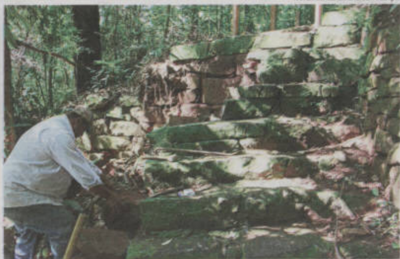
Entre outras melhorias, escadarias que cederam estão sendo reconstruídas
