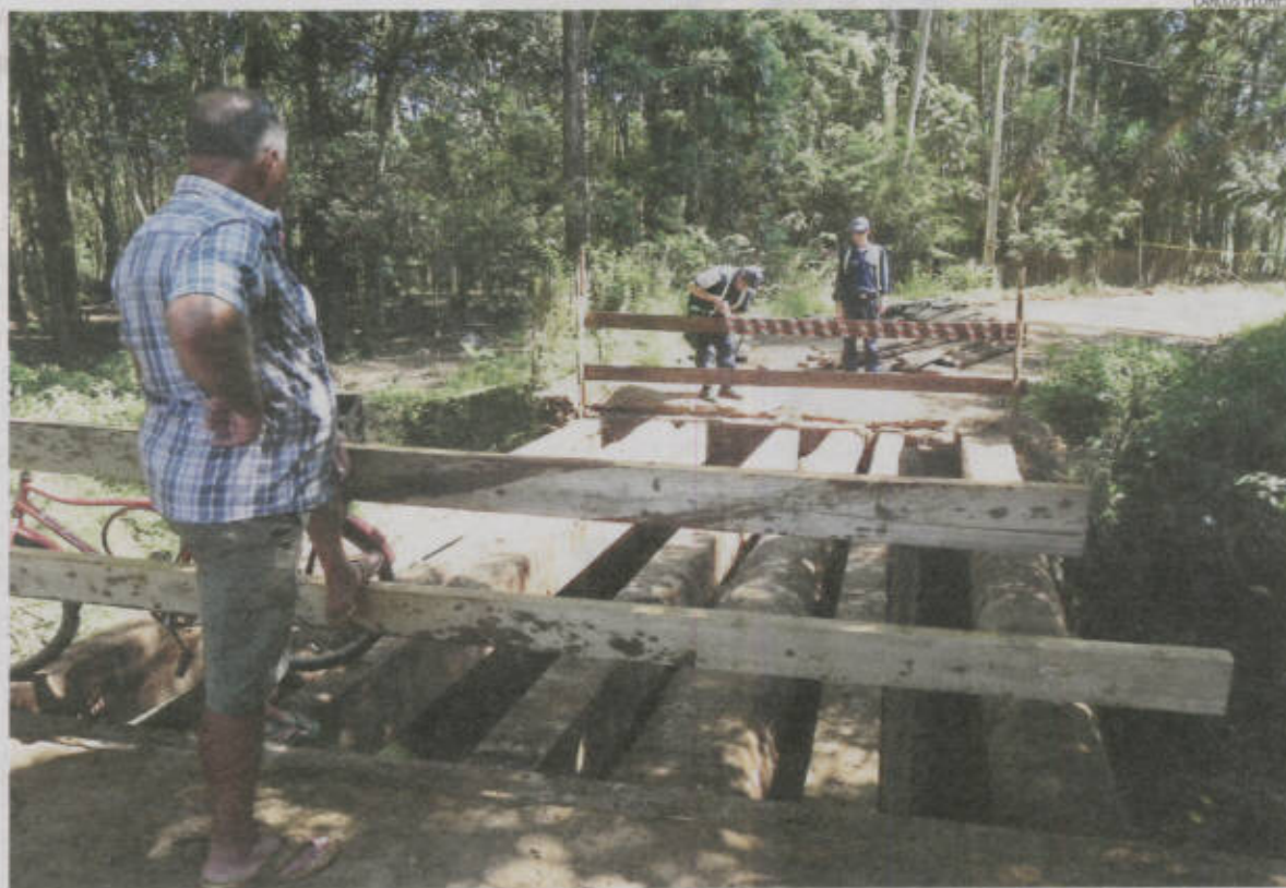
Moradores observam inspeção de equipe de servidores. Trânsito deve ficar interrompido até a conclusão da obra
