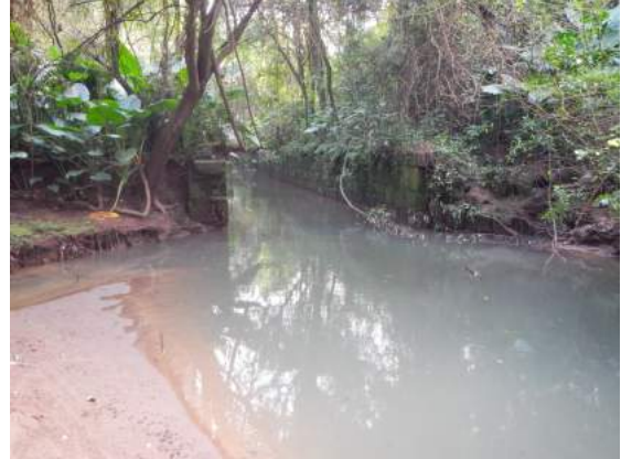
Figura 131: Final da canalização do arroio
