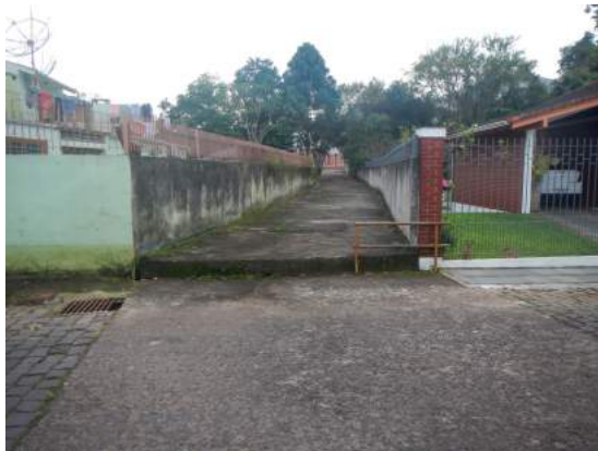
Figura 115: Construções sobre o canal
