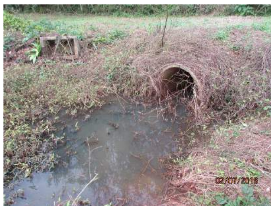
Figura 9: Canalização em área alagada
