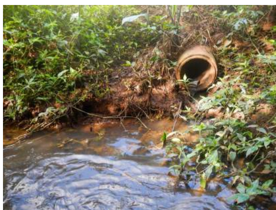
Figura 78: Saída Pluvial da Rua Ernesto Berner
