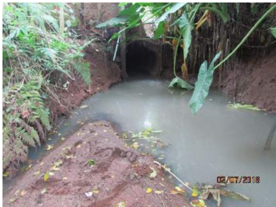
Figura 6: Primeiro local onde o arroio não está canalizado
