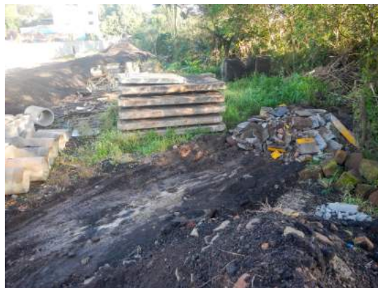
Figura 53: Depósito de entulhos, tubos e asfalto por sobre a canalização
