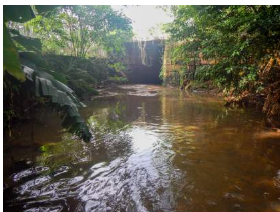
Figura 106: Trecho em que o arroio é novamente canalizado
