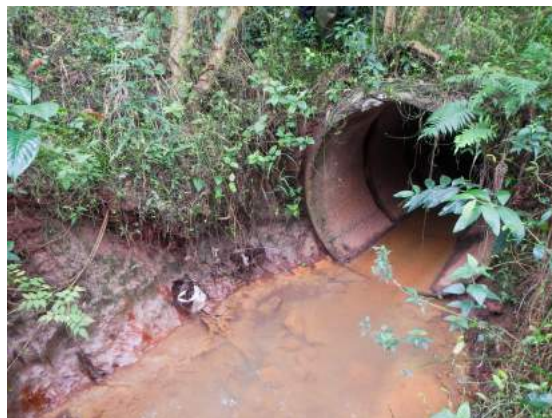
Figura 27: Abertura da canalização após o campo
