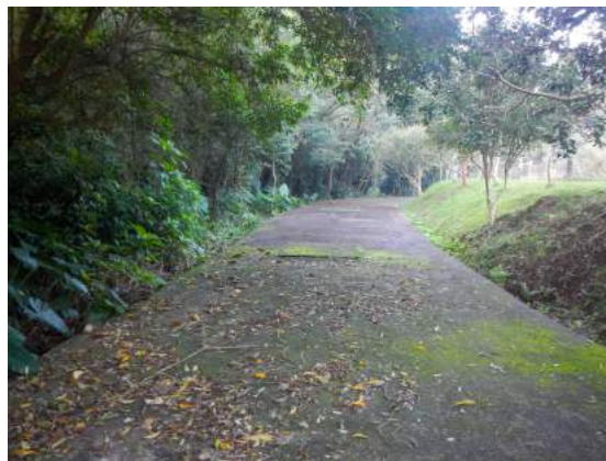
Figura 117: Canalização ao lado do lago no Parque do Engenho
