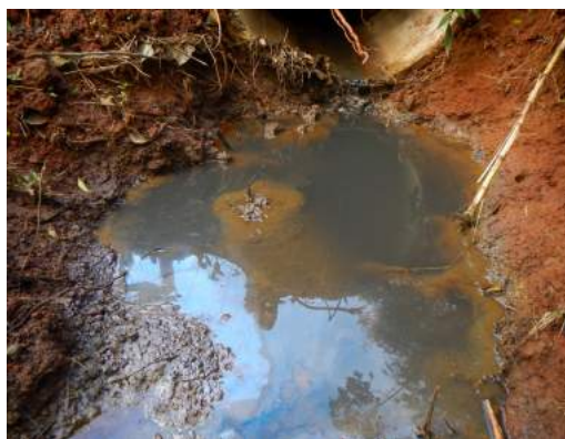
Figura 68: Cano de saída de efluentes com óleo
