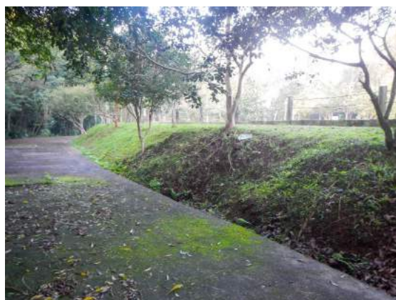
Figura 118: Canalização do Arroio do Engenho no Parque
