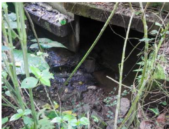
Figura 120: Abertura na canalização para entrada da água da lajea
