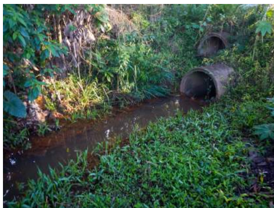
Figura 52: Início da canalização de tubo de concreto
