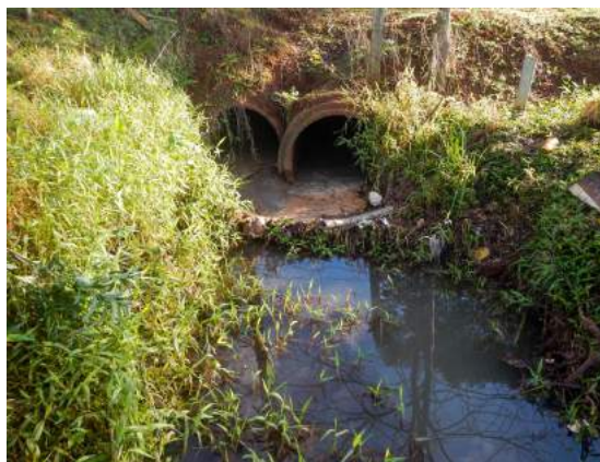
Figura 60: Córrego proveniente do bairro Santo André
