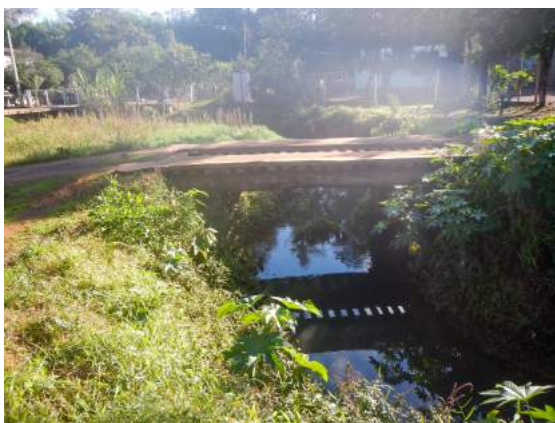
Figura 81: Ponte de acesso às residências
