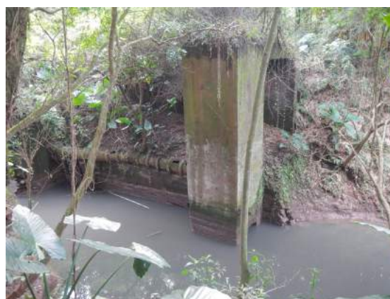
Figura 136: Gerador de energia não operante
