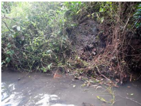
Figura 75: Esgoto in natura escorrendo pela margem do arroio
