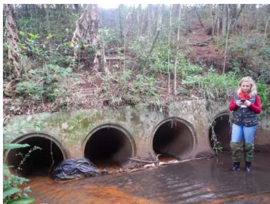
Figura 66: Início da canalização da RS 130
