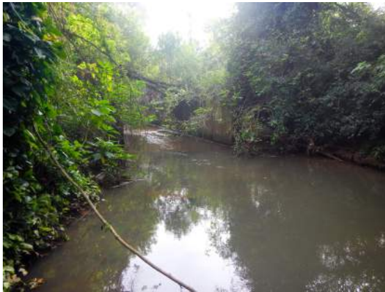
Figura 96: Final da canalização
