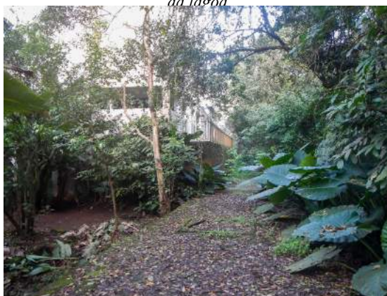
Figura 122: Condomínios construídos próximos à canalização
