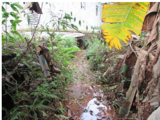
Figura 17: Detalhe do início da canalização diretamente abaixo da construção
