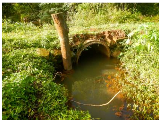
Figura 59: Ponte de acesso à propriedade
