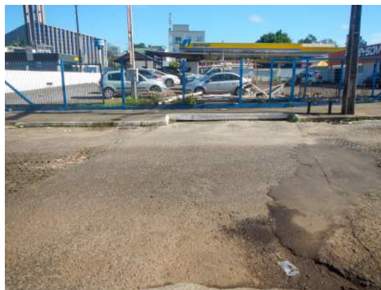
Figura 92: Canal sob os empreendimentos
