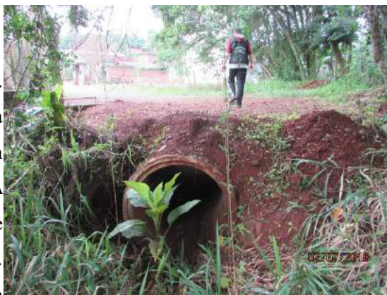
Figura 16: Canalização sob a Rua Agostinho Miorando
