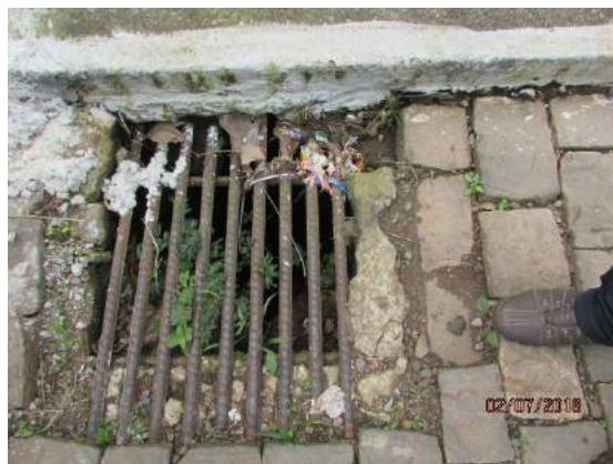
Figura 3: Caixa de entrada para a rede pluvial com acesso ao arroio do Engenho
