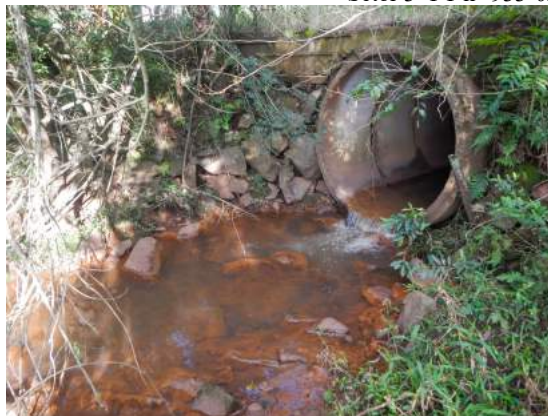
Figura 58: Final do entubamento
