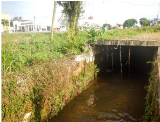
Figura 108: Final do tamponamento
