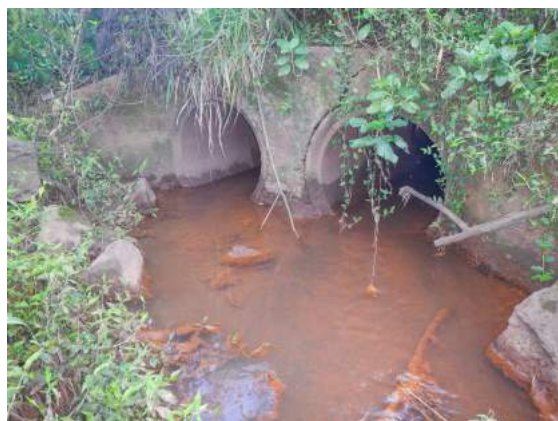
Figura 48: Canalização sob a BR 386
