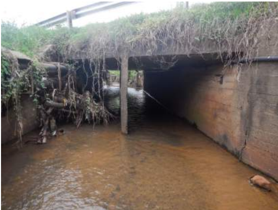
Figura 112: Arroio entre as duas pistas da BR
