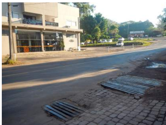
Figura 54: Visualização dos tubos de escoamento pluvial e do arroio canalizado
