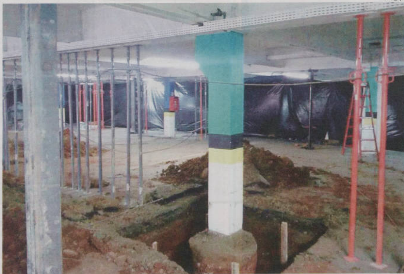
Local onde ocorre o reforço nas colunas, no lado esquerdo, ao fundo do estacionamento, está cercado por lonas
