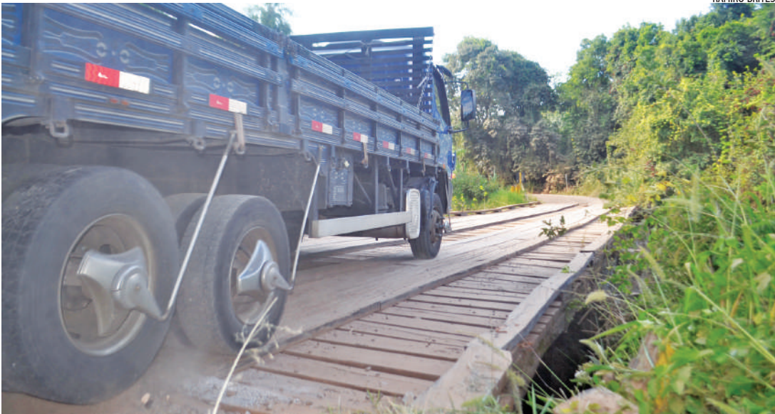
Em Linha São José, antiga ponte de madeira recebe fluxo intenso entre a ERS-129 e a RSC-453
