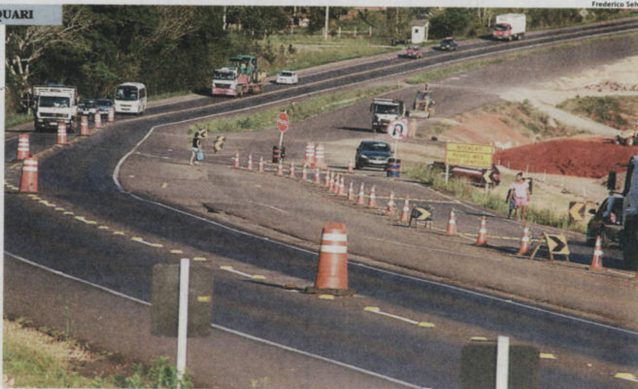
Previsão de empresa é que trechos liberados sejam concluídos em maio
