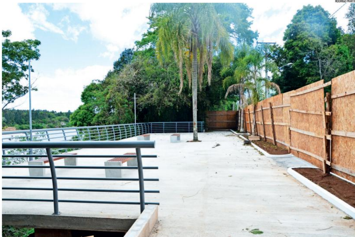
Belvedere inaugurado em junho foi fechado com tapumes. Local segue em obras. Novos empreendimentos são aguardados na rua Osvaldo Aranha
