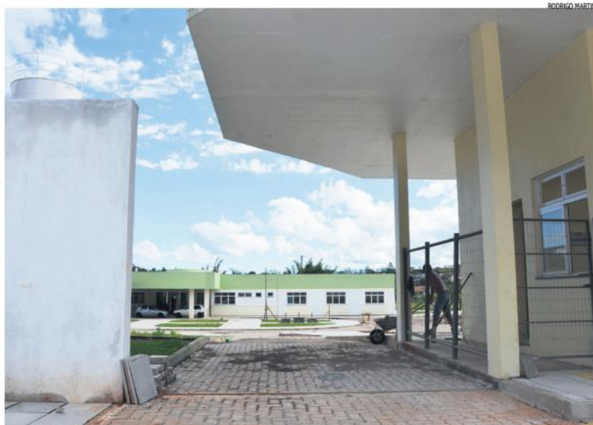
Com quase dois anos de atraso, obras seguem à mingua. Nessa terça-feira, só um funcionário trabalhava no local
