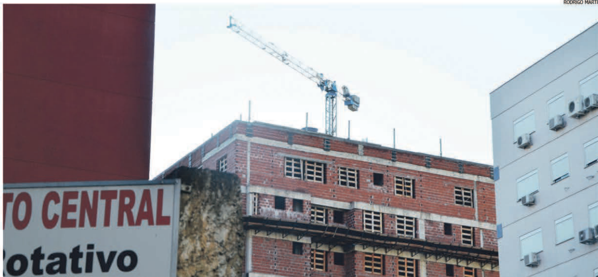
Com quase 80 mil habitantes e uma média de mil novos moradores a cada ano, Lajeado cresce verticalmente em diversas áreas centrais
