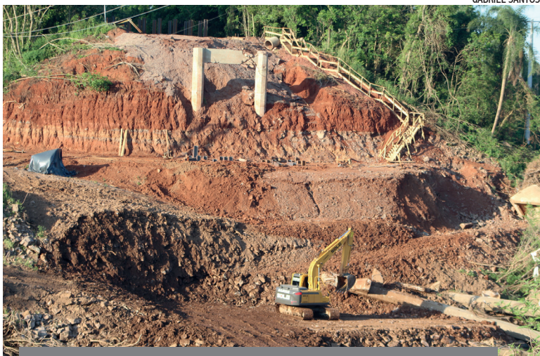
Empresa faz a base para a nova ponte sobre o Rio Forqueta. Licitação às cabeceiras será lançada na próxima semana
