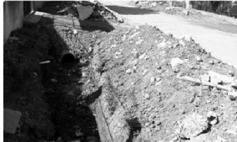
PARADAS: obras no Bairro Planalto foram interrompidas e não há data prevista para retomada
