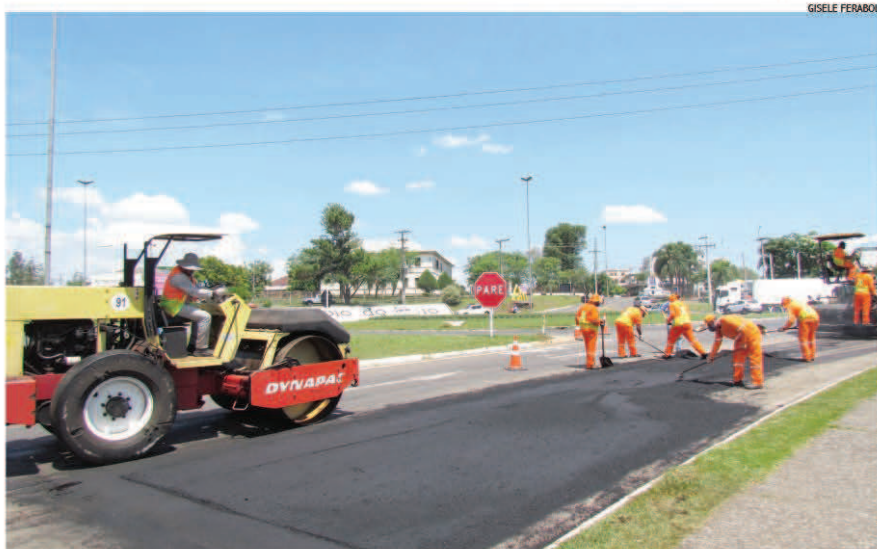
Reformas na rodovia estadual se estendem de Arroio do Meio a Encantado. Obras causam congestionamentos
