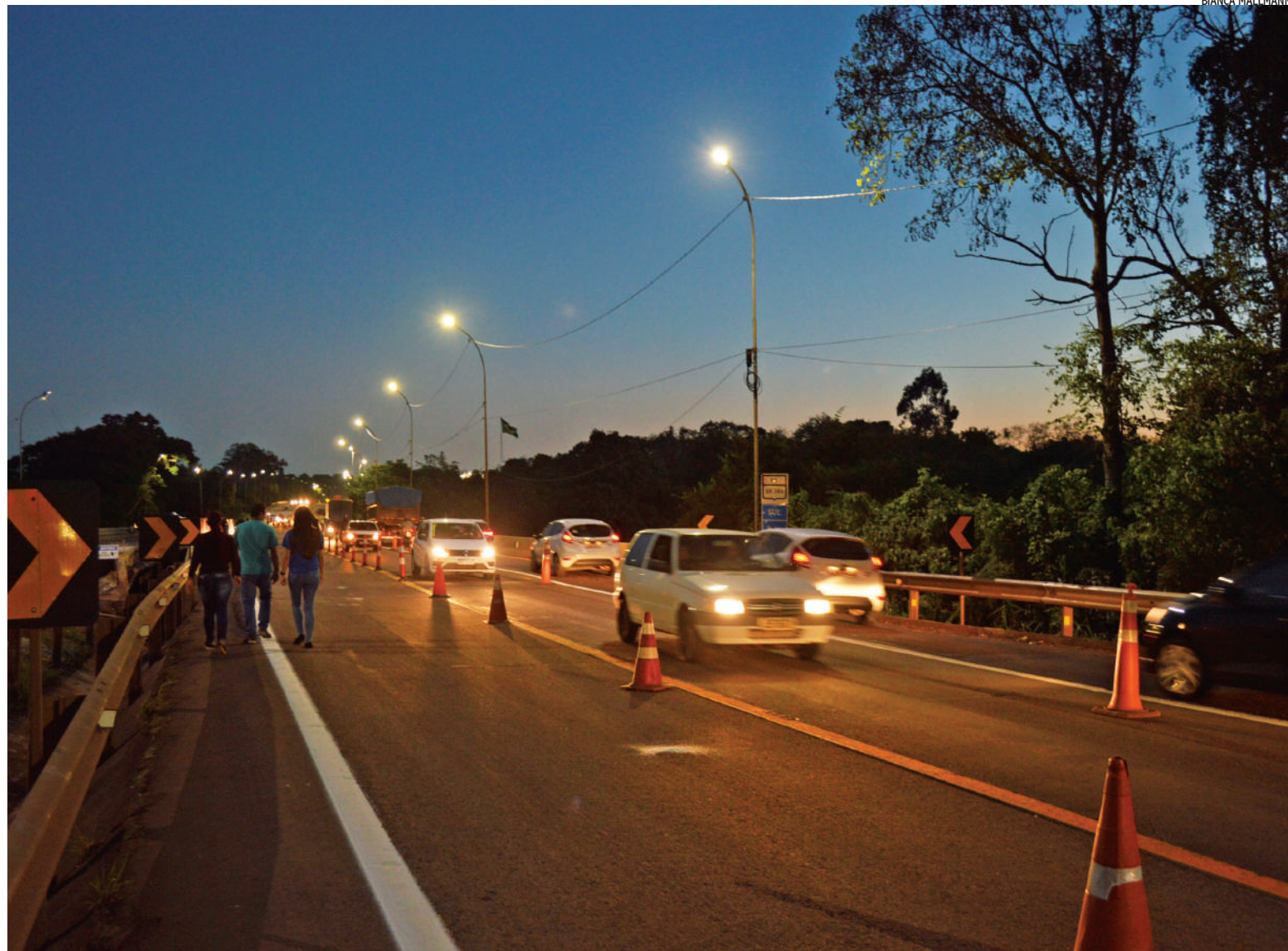
Sem a mudança, segue proibido trânsito de veículos pesados (caminhões e ônibus) na pista sul da ponte sobre o Arroio Boa Vista
