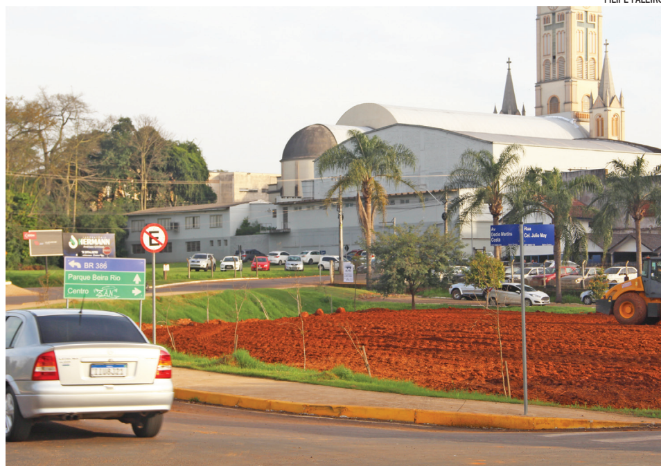
Empresa terceirizada faz a compactação do terreno. Primeira obra do novo complexo esportivo começa na segunda-feira
