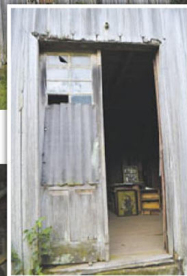
RESGATE: História que se manterá viva após restauração do prédio
